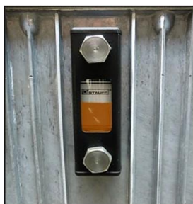
Ilust. 8-1 Nivel de llenado de aceite óptimo
