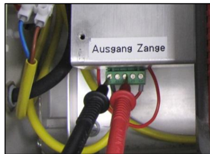
Fig. 9-3 - Misurazione della tensione di stordimento al capo E6 ed E8
