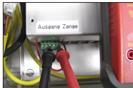
Fig. 9-5 - Misurazione della tensione di stordimento cardiaco
