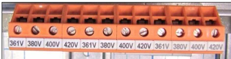
Рис. 5-12 Дополнительные входы для другого напряжения
